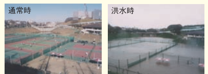
河川の急激な流出を抑えるため一時的に水を貯留する、洪水調節池を整備。
