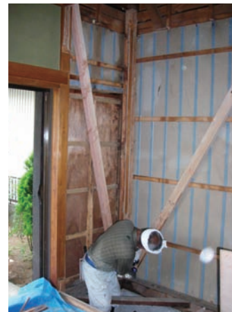
耐震補強工事を促進。 （提供＝一般財団法人日本建築防災協会）
