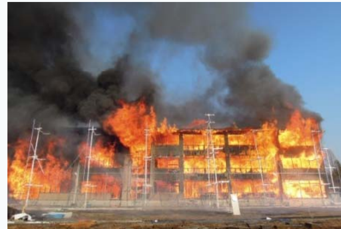
火災最盛期の様子(平成24年2月22日)
