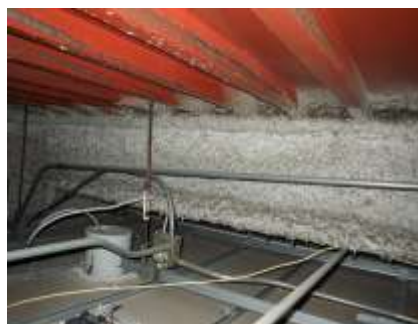
実地研修会場の様子 (2 階事務室天井裏の吹付け材が使用されている部位)
