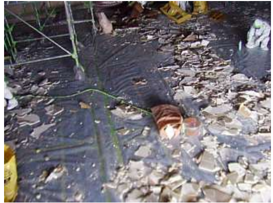
作業中の床状況
