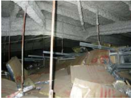
天井裏（作業前）
