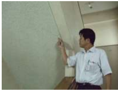
写真8 除去対象の階段部分
