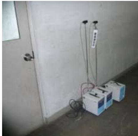
機械室前廊下
