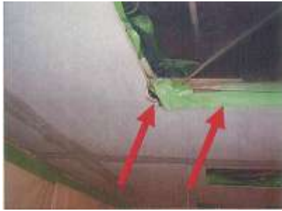
写真4 天井照明撤去後（隙間が多い）
