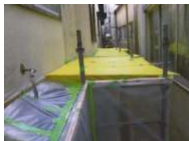
写真2 プラスチックボードによる隔離養生保護
