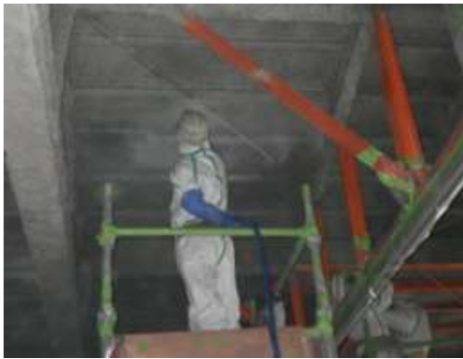
吹き付け面への薬液散布
