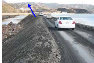
堤防嵩上げ状況 (第1ステップ)
