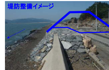
堤防嵩上げ (第3ステップ)
