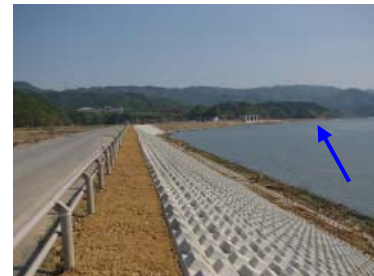
堤防嵩上げ、護岸張り状況 (第2ステップ)
