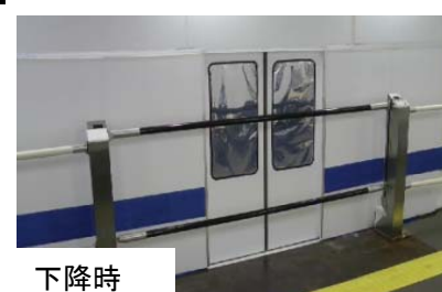
＜昇降バー方式ホームドアの開発＞
