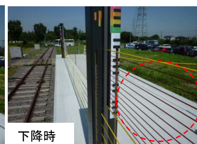
＜昇降ロープ式ホームドアの開発＞
