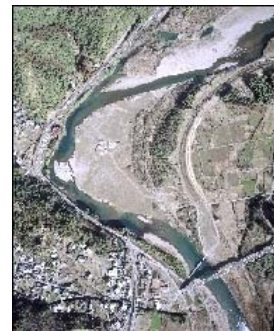
高水敷切り下げ後
