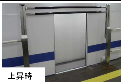
＜昇降バー方式ホームドアの開発＞
