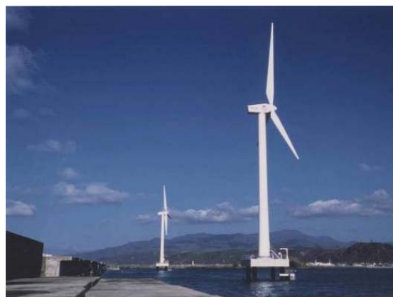
〈洋上風力発電施設：瀬棚港600kW×2〉
