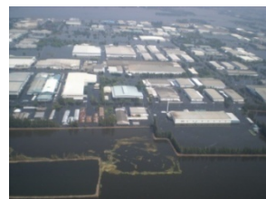
日本企業が多く進出しているロジアナ工業団地の状況
