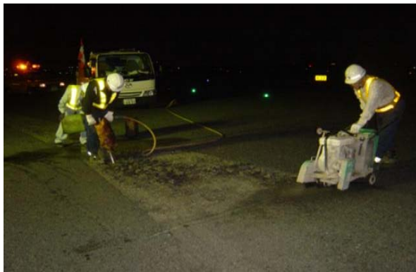
点検を踏まえた補修の実施
