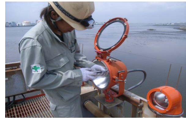
点検を踏まえた補修の実施
