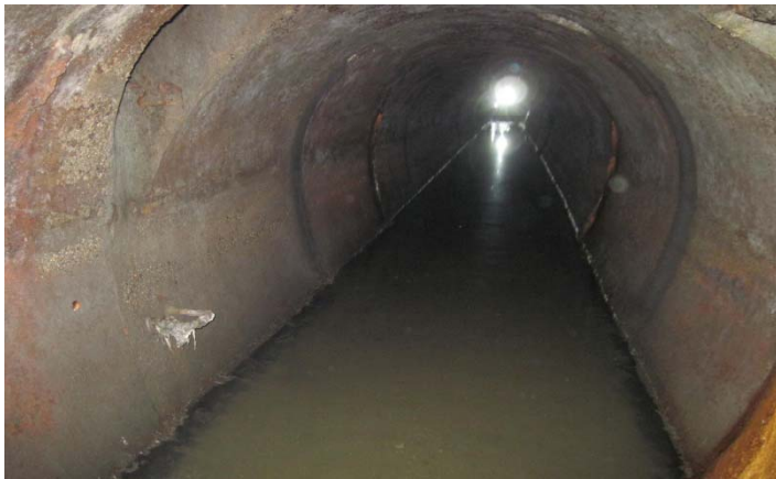
大正町幹線(愛知県名古屋市) 1930(昭和5)年頃整備(約82年経過)
