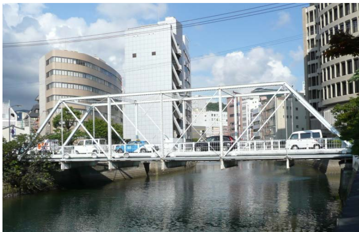
出島橋(長崎県長崎市) 1910(明治43)年架設(約102年経過)
