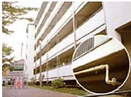
<配管のメンテナンス>
