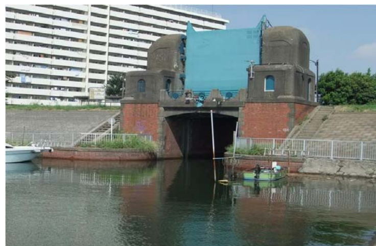
六郷水門(東京都大田区:多摩川) 1930(昭和5)年設置(約82年経過)
