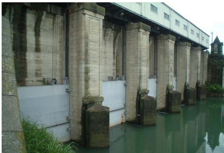
第十樋門(徳島県上坂町:吉野川) 1922(大正11)年竣工(約90年経過)
