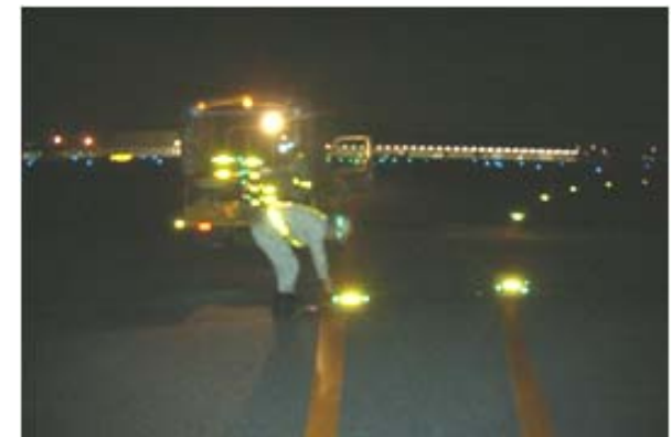
航空灯火施設の点検
