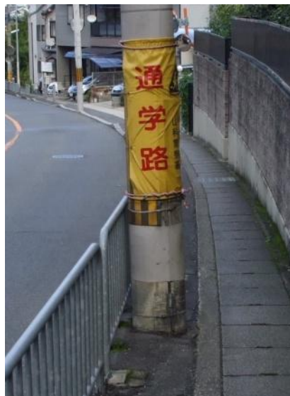
通学路で通行の支障となっている電柱
