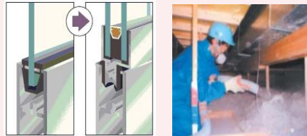
複層ガラスへの交換、天井の断熱改修 ※被災地以外については、7月4日に予約受付終了
