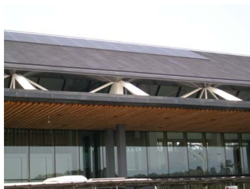
■太陽光発電パネルの設置
