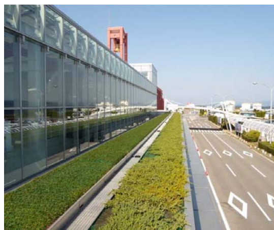
■ 旅客ターミナルビル庇の緑化
