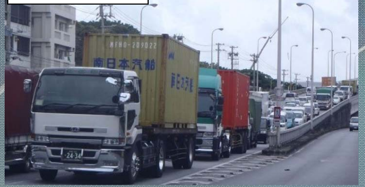
①港湾1号線 泊大橋
