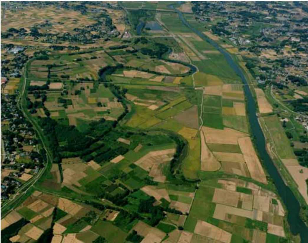
図 2-2 太郎右衛門自然再生地斜め空中写真（平成 14 年度）
