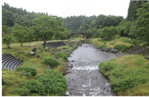
高原町内にある砂防施設の一つである高干穂遊砂地。土石流発生の際のポケットとなる施設であるが、普段は親水公園として利用されている。
