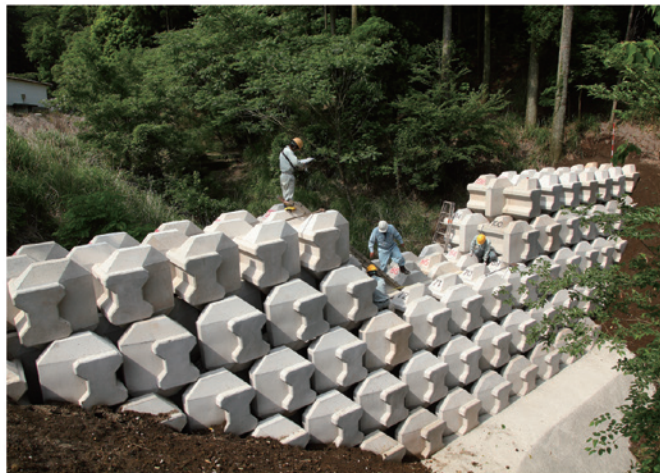
大型ブロックを利用した土石流対策。短期間で土石流に対するポケットを新たに確保するために行っている。大型ブロックは1個あたり2トン以上の重さがある。
