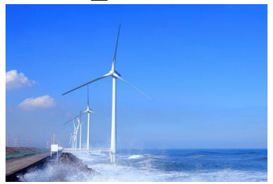
鹿島港（茨城県神栖市） 2,000kW×7基
