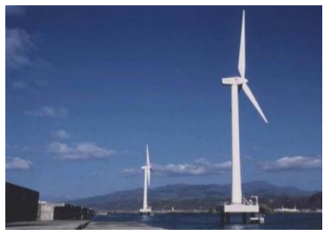
瀬棚港（北海道せたな町） 600kW×2基
