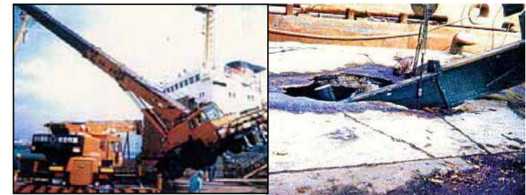
岸壁の陥没によるクレーンの倒壊事故
