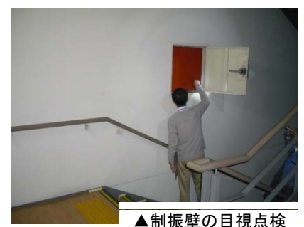
▲制振壁の目視点検
