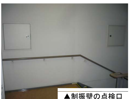
▲制振壁の点検口
