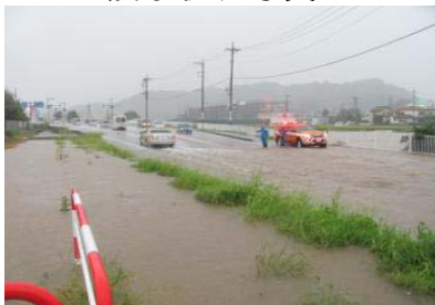
① 浸水状況写真
