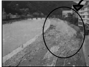
こう水により被災した河川敷公園
