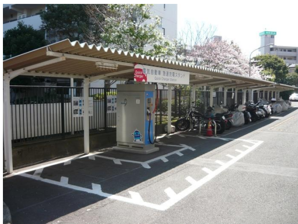
事例：神奈川県茅ヶ崎市「市営茅ヶ崎駐車場」
