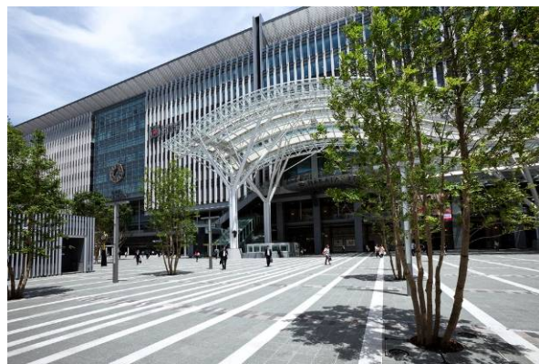
新博多駅ビル。縦格子のファサードに、通りからのビスタを意識したガラスカーテンウォールや大屋根がシンボリックな景観を形成。広場空間はイベントの実施等、賑わい・交流の核となっている。
