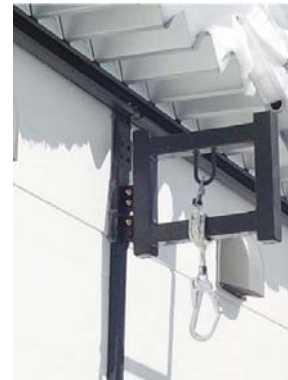
事例4: 雪下ろしのための屋根昇降用ハシゴ固定金物の設置(長野県栄村)
