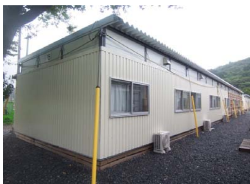
事例3: 追加工事による外断熱
