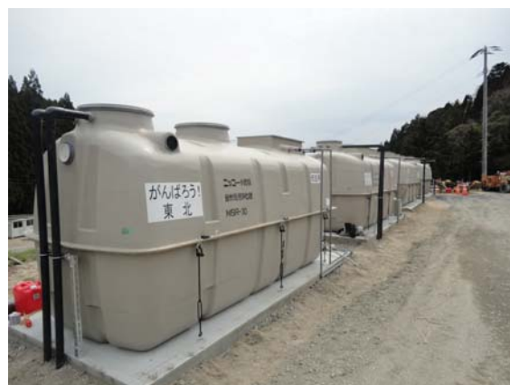
事例2:浄化槽の設置
