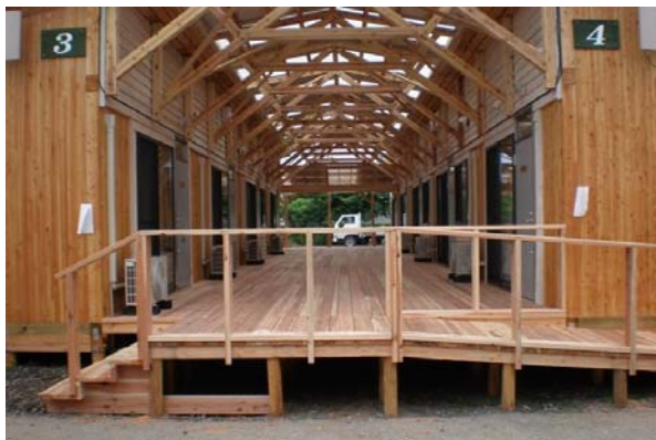
事例5: 玄関を向かい合わせにし、バリアフリー化のためのデッキを設置(岩手県遠野市)
