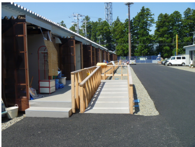
事例3: 住戸前の舗装、スロープの設置
