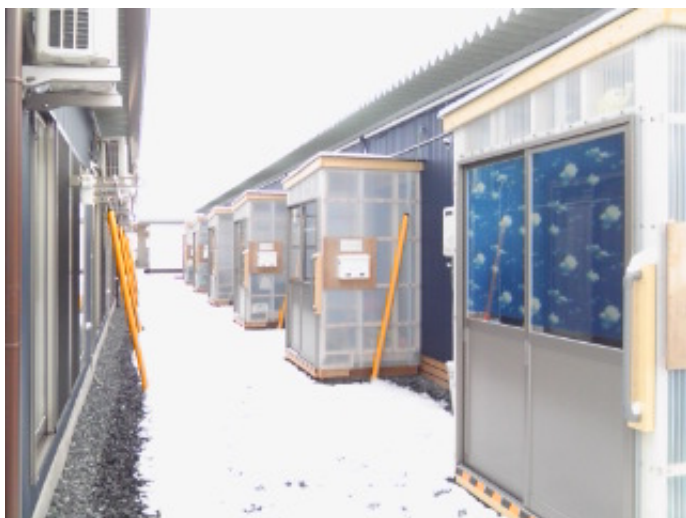
事例1: 風除室の設置(宮城県石巻市)
