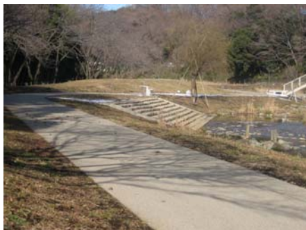
メインルートの舗装
