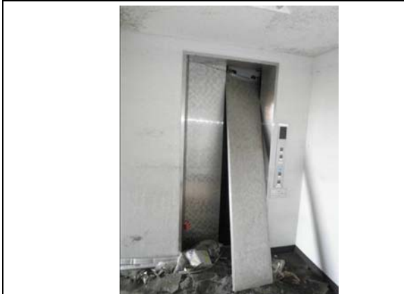
写真7 2階のエレベータ扉
