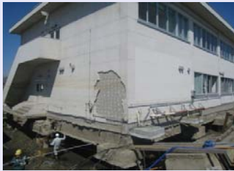
▲津波で庁舎下部、 の地盤が流出
