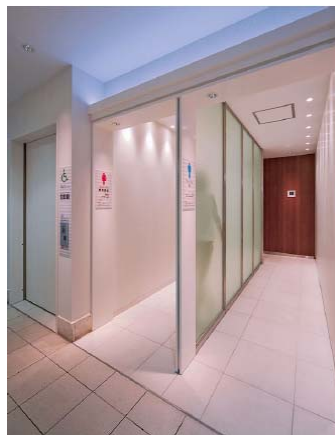
男女トイレの通路の間に、半透明のガラスのパーティションを設置。人の気配を感じることができるので、入口での衝突を防ぐ効果がある。
