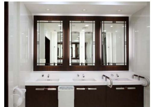
女性トイレ内の洗面器コーナー： 手すりやベビーチェアを設置、手前のバーは荷物や傘、杖などをかけることができる。
