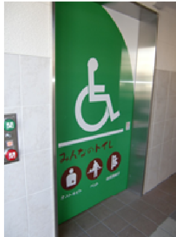
車いす使用者等用便房入口ドア：内部に配置されている設備のピクトグラムをデザインした自動引戸になっている
