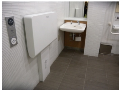
多機能トイレ内部：オストメイト用汚物流し、おむつ替えシートを設置
