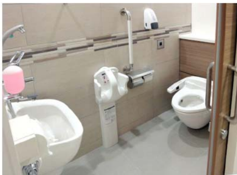
男性トイレにあるオストメイト対応汚物流しを備えた大便器ブース
