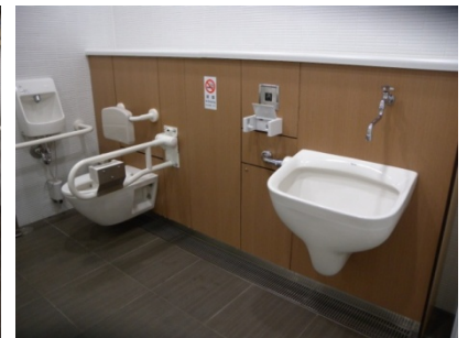
多機能トイレ内部：オストメイト用汚物流し、おむつ替えシートを設置
