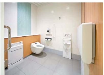
男性・女性トイレ内に各1か所あるひろびろブース：ベビーカーで入れる広さに、おむつ替えシート、着替え台、ベビーチェアを設置
