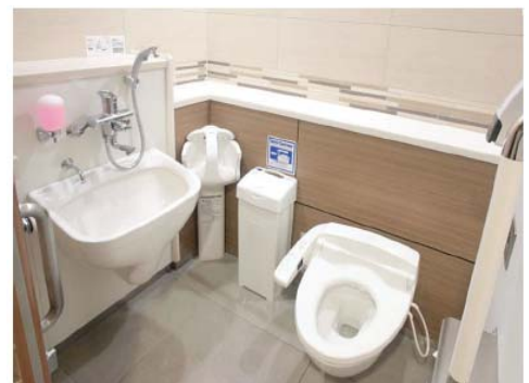
女性トイレにあるオストメイト対応汚物流しを備えた大便器ブース
