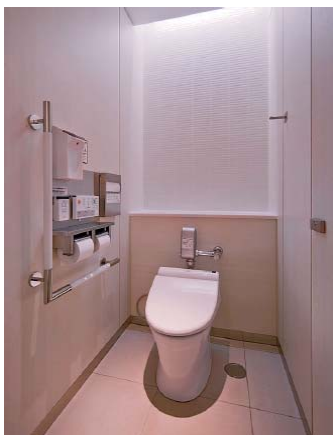
全ての女性トイレには、腰掛便器に手すりとベビーチェアを設置
