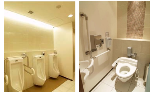
男性トイレ内の低リップ小便器。手前の便器には手すりを設置。
