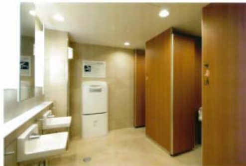
女性トイレ： 便房内へのベビーチェア、着替え台の設置 おむつ替えシートは便房の外に設置
