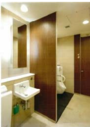
男性トイレ： 小便器の手すり設置 ベビーチェアの設置
