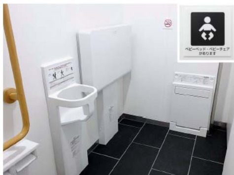
男性トイレ内にある広めの簡易型多機能トイレには、子ども連れへの配慮として、おむつ替えシート、ベビーチェア、着替え台を設置
