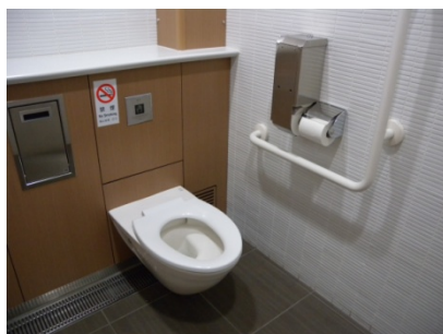
女性トイレにある広めトイレ ベビーカーごと入れる
