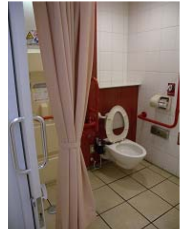
多機能トイレ内 介助者とともに使用する場 合に配慮してカーテンが設 置されている
