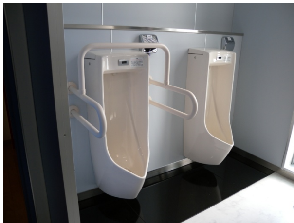
男性トイレ小便器への手すりの設置。(6F男性 トイレ)
