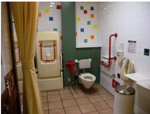
多機能トイレ内 介助者とともに車いす使用者がトイレ使用する場合、手前のカーテンを引くことで目隠しができる
