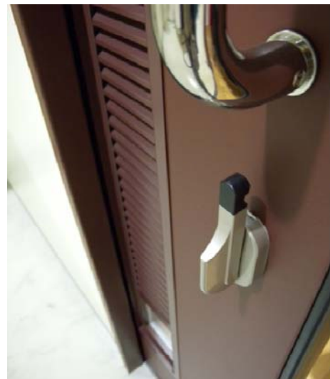
少ない力で操作可能な手動式引き戸の鍵。 (6F多機能トイレ)
