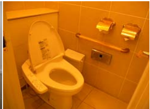
一般便房内（女性トイレ）
