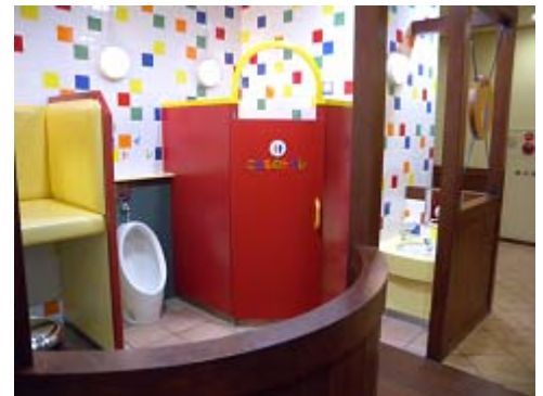
写真③ 一般トイレの前にある子ども用トイレ： 左側におむつ替えの台、中央に男児用小便器、赤いドアの中は小児用大便器が配置されている
