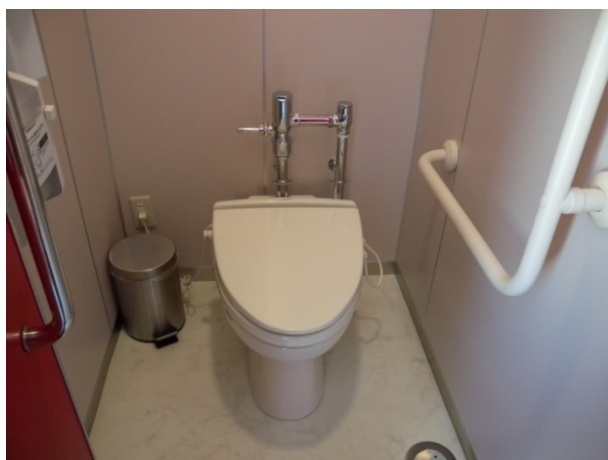
一般トイレの大便器への手すりの設置。扉は折戸。（7F女性トイレ）
