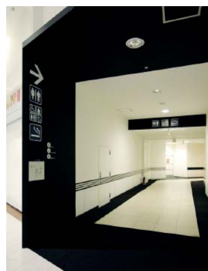
ユニバーサルデザイントイレの入り口：トイレの入り口まで黒いラインを表示し、わかりやすく誘導している （写真 TOTO COM-ET より引用）
