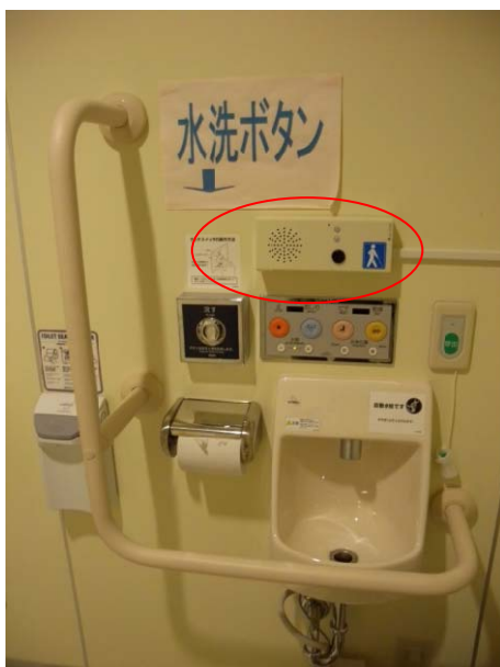
1階多機能トイレ内部の音声案内設備:建物完成後に視覚障害者の意見を反映して後付けされたもの
