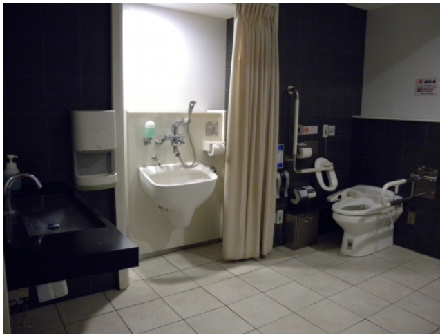
みんなのトイレ：ゆとりあるスペースに汚物流し、大型ベッド等が配置されている。扉横には、トイレ内の設備を案内する音声案内が設置されている。
