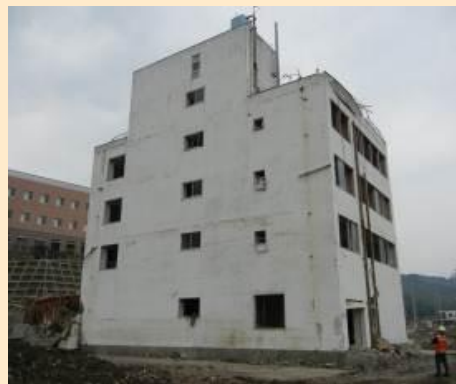
残存する建築物(a) (女川町, RC造4階)
