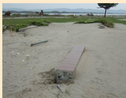
崩壊した柱(c) (亶理町, CB造)
