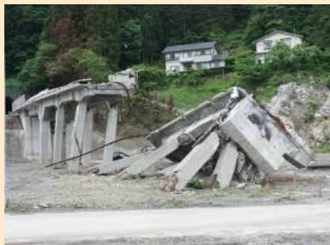
崩壊した鉄道橋(c) (田野畑村, RC造)
