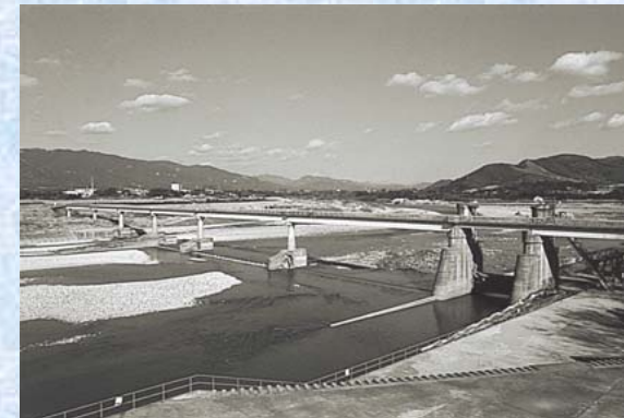
豊川用水事業により 松原用水と牟呂用水 の取水口を統合した 牟呂松原頭首工が 完成(S43年)
