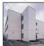
既存低層庁舎へのエレベーターの設置
