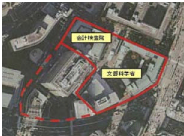
中央合同庁舎第 7 号館の計画予定地の現況
