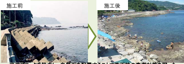
消波ブロックを除去し、自然石を配置することで荒天時の高潮対策を図った海岸の例
