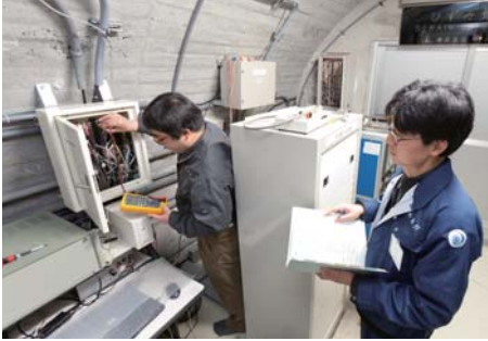
歪地震計のセンサーからの出力電圧をチェック。年に数回のメンテナンスは不可欠だ。
