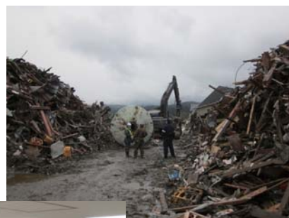
「くしの歯」作戦によるルート啓開作業。自衛隊や警察と連携して作業を進める中、地域の建設業者が大活躍した。
