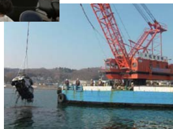
港湾では浮遊物やがれきの回収を進め、3月23日までに航路を啓開。仙台港や大船渡港など、太平洋側の10港すべてで、海からの緊急支援助物資受け入れが可能になった。
