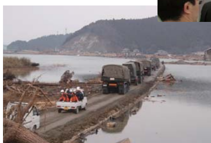
河川も津波や地盤沈下で大きく被災した。北上川(石巻市釜谷地区)では流出した道路兼用堤防をわずか1日で1車線分を緊急復旧し、3月14日に供用を開始した。
