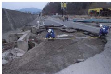
被災地域の救援、復旧に欠かせない輸送路を早期に回復させるため、被災状況調査班が津波で被災した国道の調査を実施。(岩手県山田町 国道45号)
