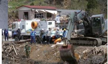
自衛隊による行方不明者の捜索のため、津波による湛水箇所の排水支援を応急対策班が排水ポンプ車により実施。(岩手県陸前高田市内)
