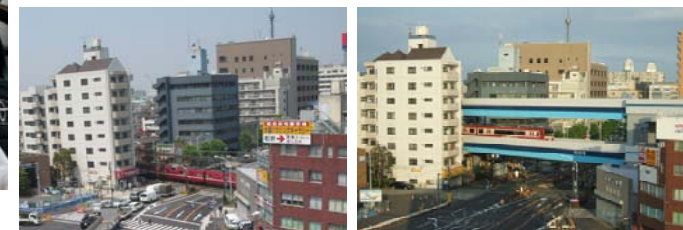
京浜急行電鉄本線及び同空港線 連続立体交差事業(東京都)
