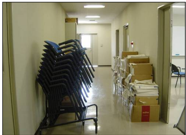
〈避難通路の障害物〉
