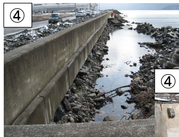
半崎1号護岸 ・基部 根ブロック71.6m、 被覆ブロック91.6m被災 ・捨石一部露出 ・終端部のパラペットの転倒倒壊あり
