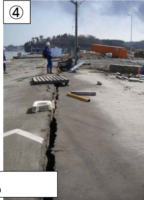
貞山2号棧橋 ・エプロン沈下0.2m
