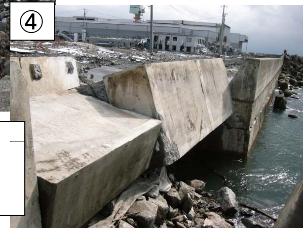
半崎1号護岸 ・基部 根ブロック71.6m、 被覆ブロック91.6m被災 ・捨石一部露出 ・終端部のパラペットの転倒倒壊あり
