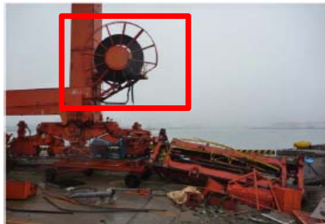
漂流物による巻取装置の破損
