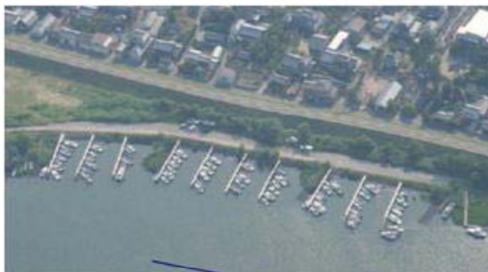
資料Ⅳ－１２ 舟艇係留施設
