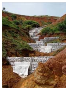
<谷止め実施状況>
