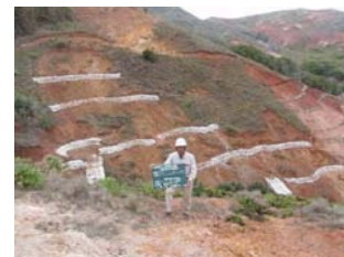
<土留め実施状況>
