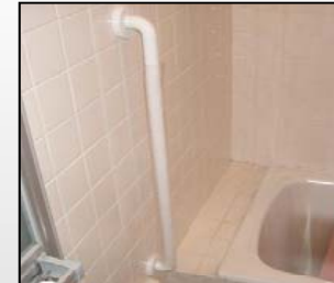
浴室内部手すり
