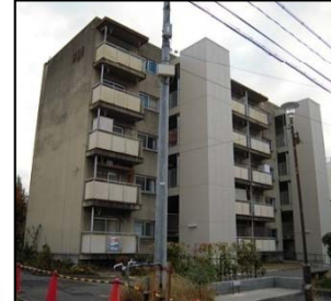
エレベーター増築
