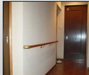
住戸内手すり
