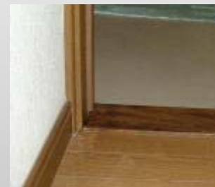
敷居段差の解消
