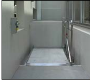
玄関段差解消リフト設置
