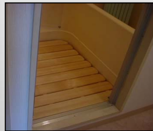
すのこによる浴室段差解消
