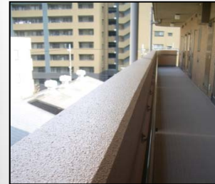
共用廊下手すり
