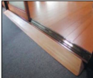
部分スロープ設置
