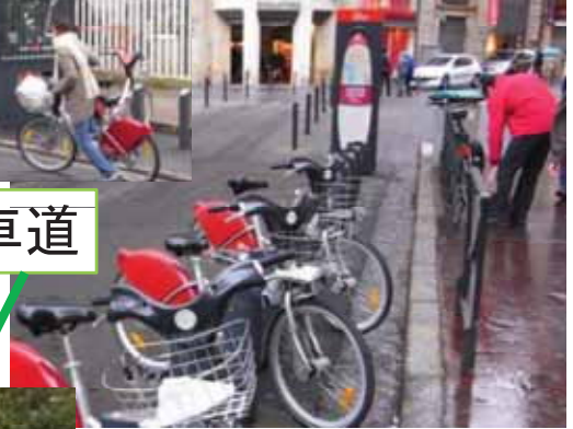
歩道を削って車道レベルで設置された例 (パリ, シャンゼリゼ近く)
