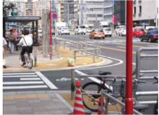
交差点部で屈曲して横断帯に繋がる例(名古屋市)
