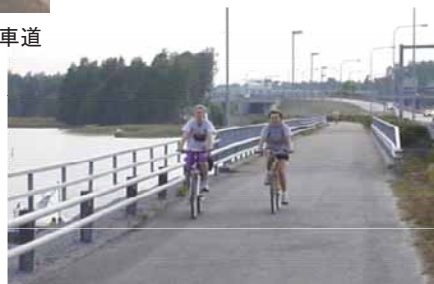
高速道路沿いの自転車道(エスポ, フィンランド)
