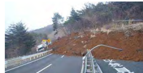
写真 国道4号伏拝地区の土砂崩落状況(H23.3.11)
