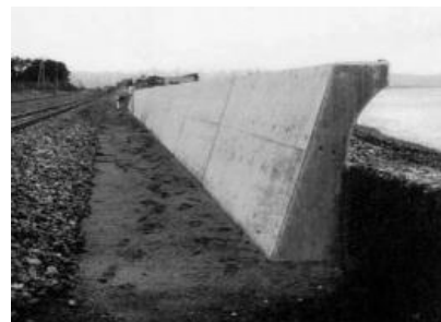
【護岸壁の一例】
