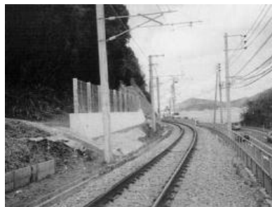
【落石防止擁壁の一例】
