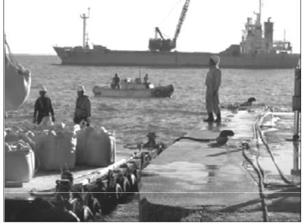
【南鳥島における荷役作業の現状】 港湾施設が整備されていないことにより 台船に積み替えて物資等を陸揚げ
