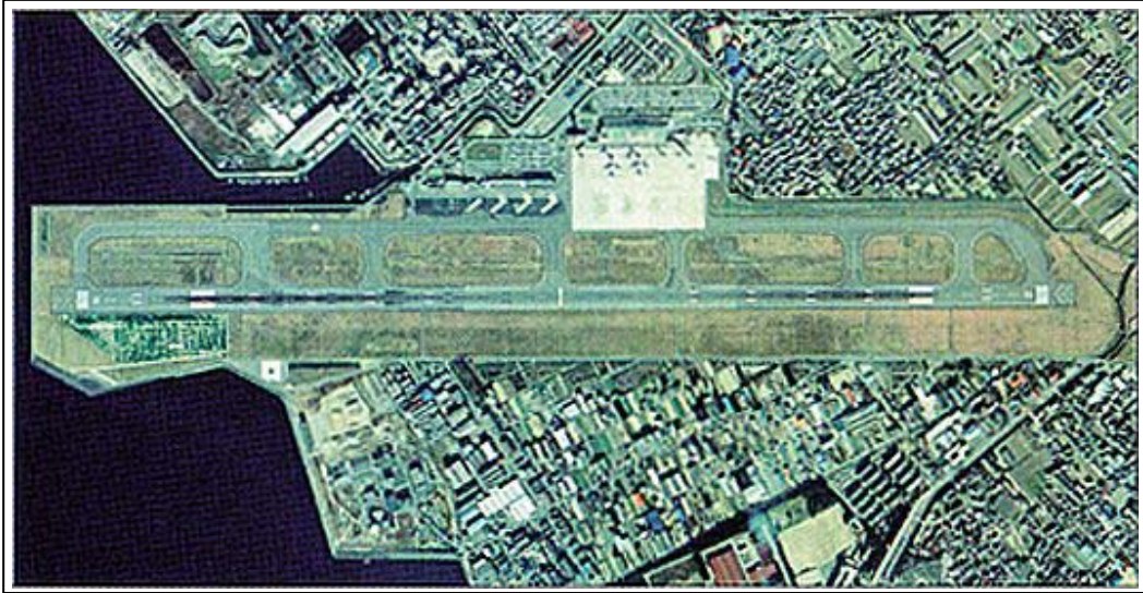
「国土交通省 四国地方整備局 松山港湾・空港整備事務所」提供
