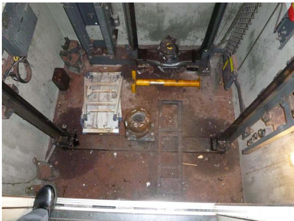
写真3 地下1階乗り場から見たピット
