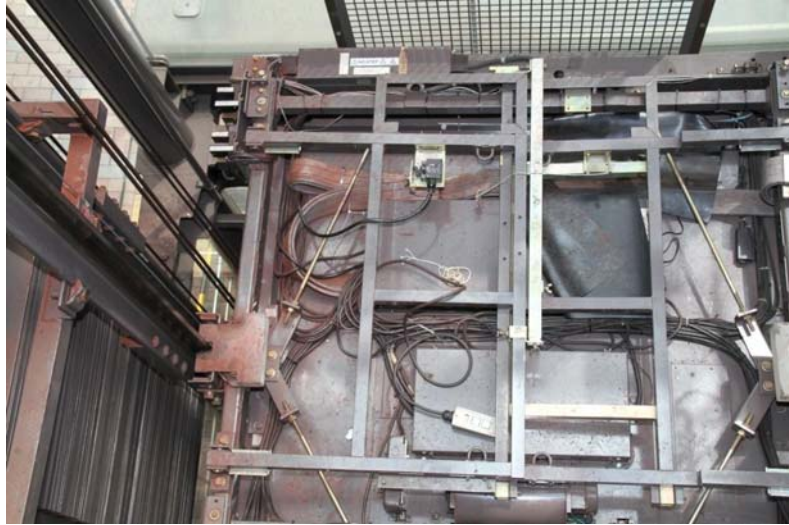
写真 9 渋谷駅東口歩道橋エレベーターかご上
