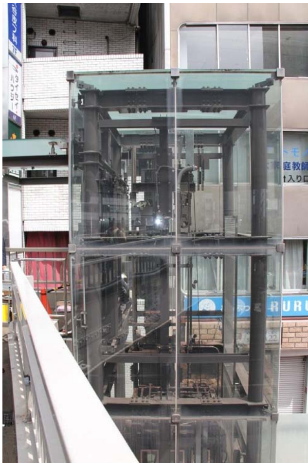
写真 10 渋谷駅東口エレベーター昇降路頂部
