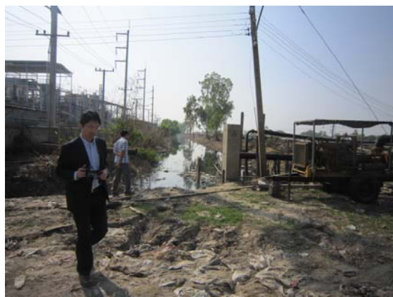
被災状況調査(ナワナコン工業団地)
