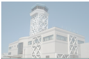
管制塔等の倒壊防止
