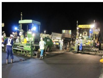
（誘導路舗装の改良）
