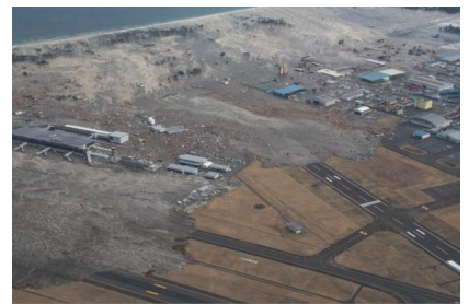
東日本大震災における仙台空港への津波襲来状況
