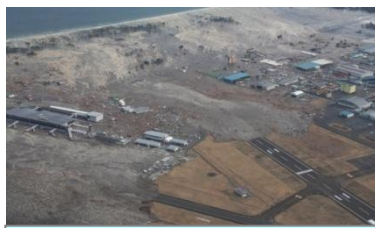
仙台空港への津波襲来状況
