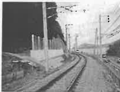
【落石防止擁壁の一例】
