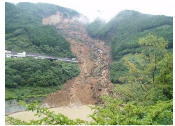
2012年 台風12号 国道169号(奈良県川上村迫)
